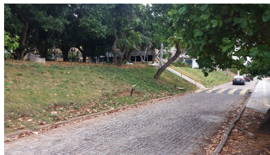
Figura 08: Trechos sem calçadas adjacentes a faixas de rolamento
